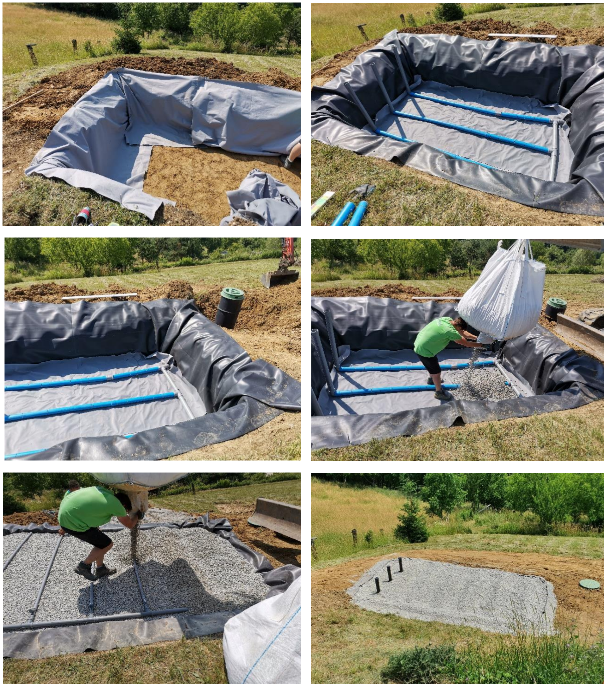
Slika 24: Fotografije prikazujejo izgradnjo RČN na Grajenščaku (vir: LEA Spodnje Podravje, 2021)
